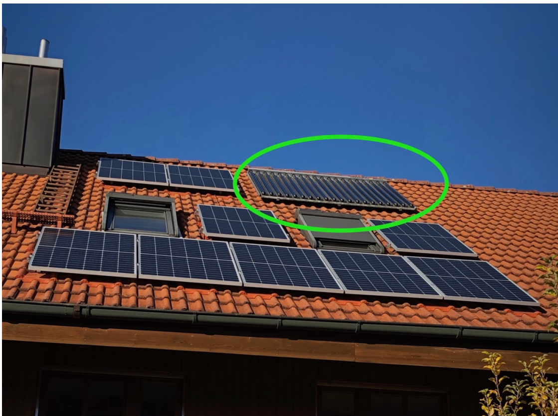
Nachgerüsteter Röhrenkollektor mit ca. 2x2m (im grünen Kreis)
