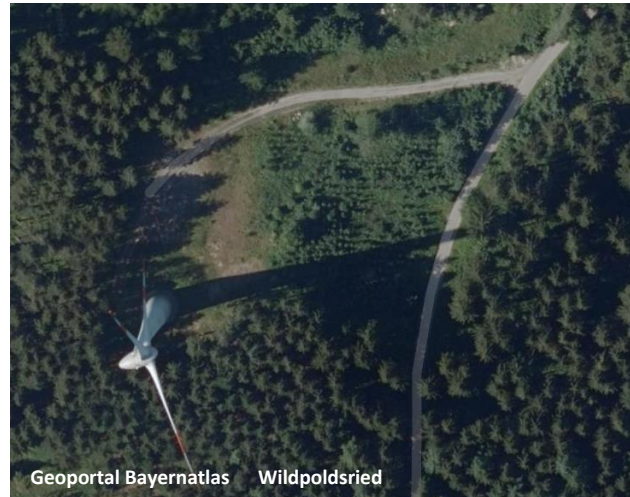
WEA-Standort wenige Jahre nach Bau
