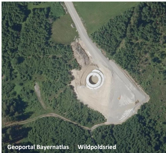
WEA-Bauplatz im Wald
