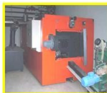
Hackschnitzel- heizzentrale
