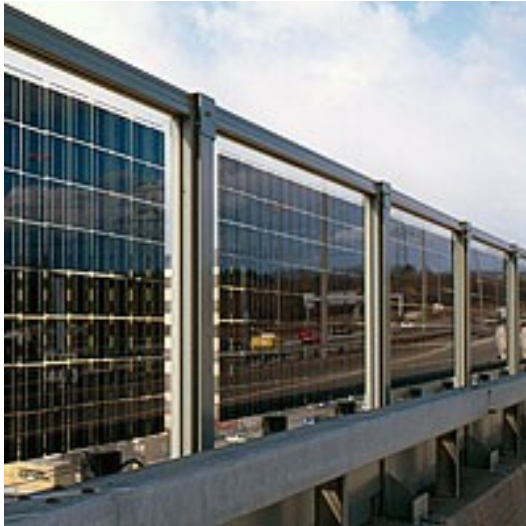
Bild 5. Innovativer Schallschutz mittels bifacialer Photovoltaik
