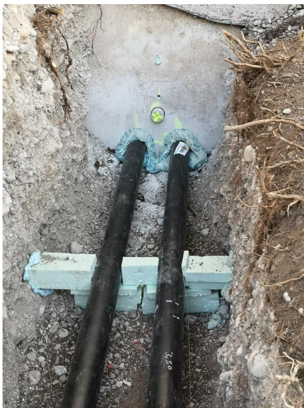
Hausanschluss mit Kernbohrung im Gebäude (inkl. Glasfaser)
